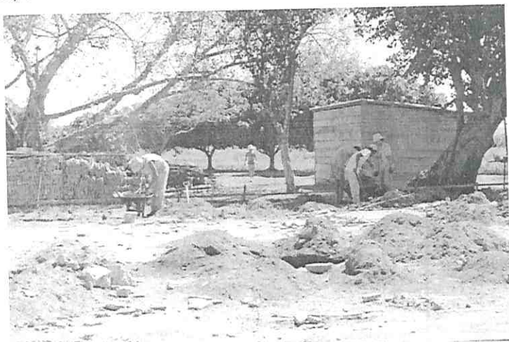
Foto 4 – Áreas das obras – piso da antiga construção.
