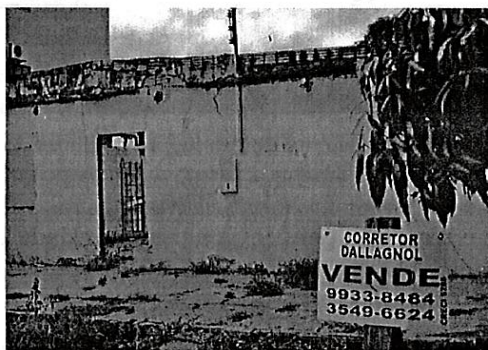
Figura 11 – Imagem de casa em ruínas na Rua Ronda Alta em Lucas do Rio Verde.
