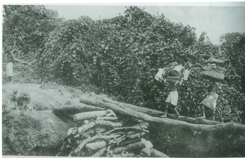
Figuras 10 250 (acima) e 11 251 (abaixo) – Pontes para a Travessia de Rios, a primeira delas conectando pedras com troncos de madeira, a segunda com troncos estendidos acima do leito dos rios.
