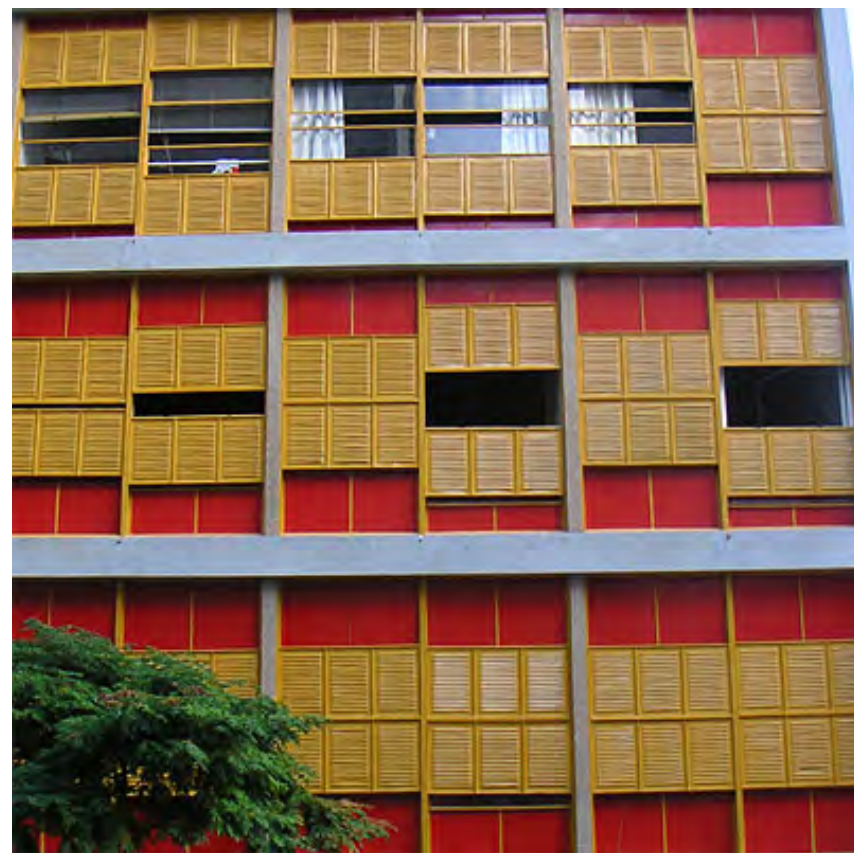
Janelas do edifício Louveira
