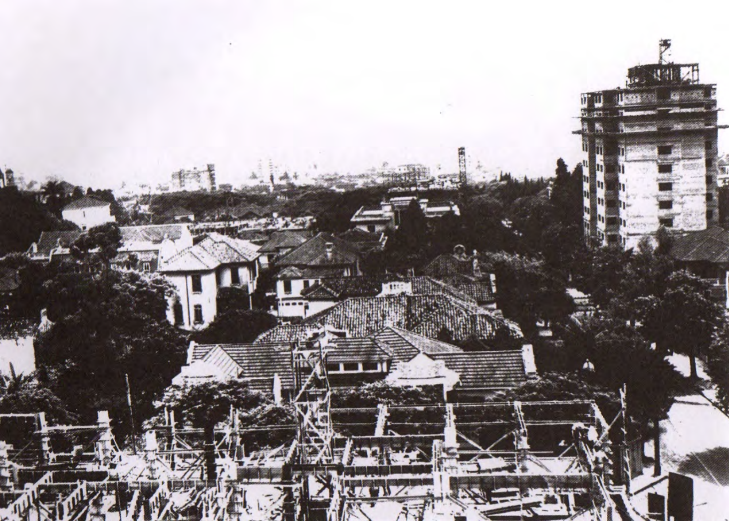
Vista de Higienópolis do Edifício Piauí, e à frente o Sabará ainda em construção
