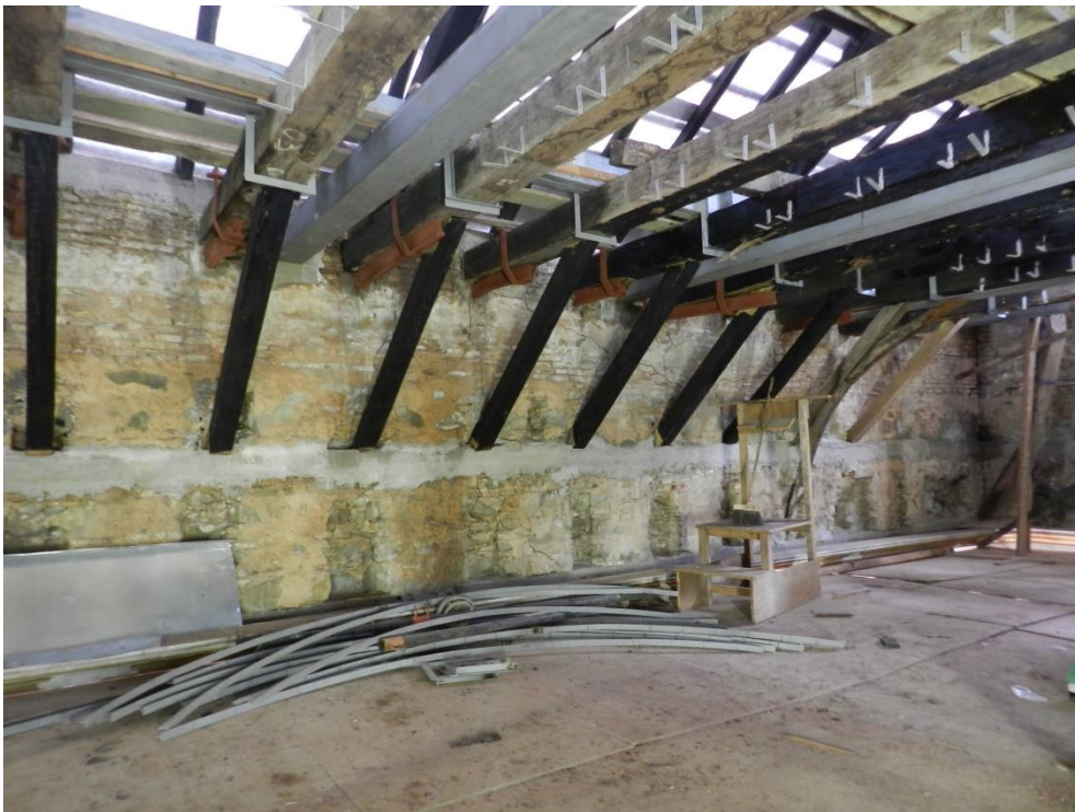
Figura 12 – Recomposição da estrutura. Colocação de vigas e cambotas metálicas. Salvador, Bahia. Acervo da autora - fotografia digital, 2015.
