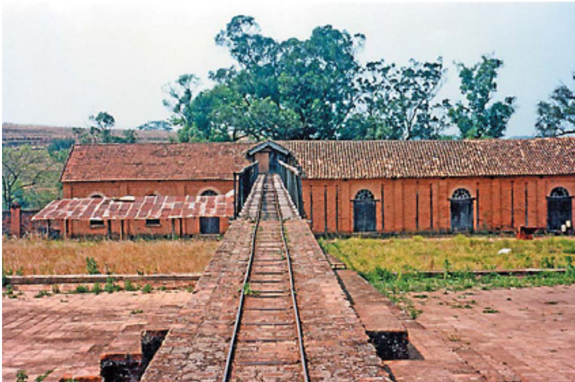
Fig.8 – Fazenda São Vicente em Campinas. Foto atual. Detalhe do sistema de trilhos e vagonetes para transporte de grãos dos terreiros para a casa de máquinas. (SILVA; 2006).
